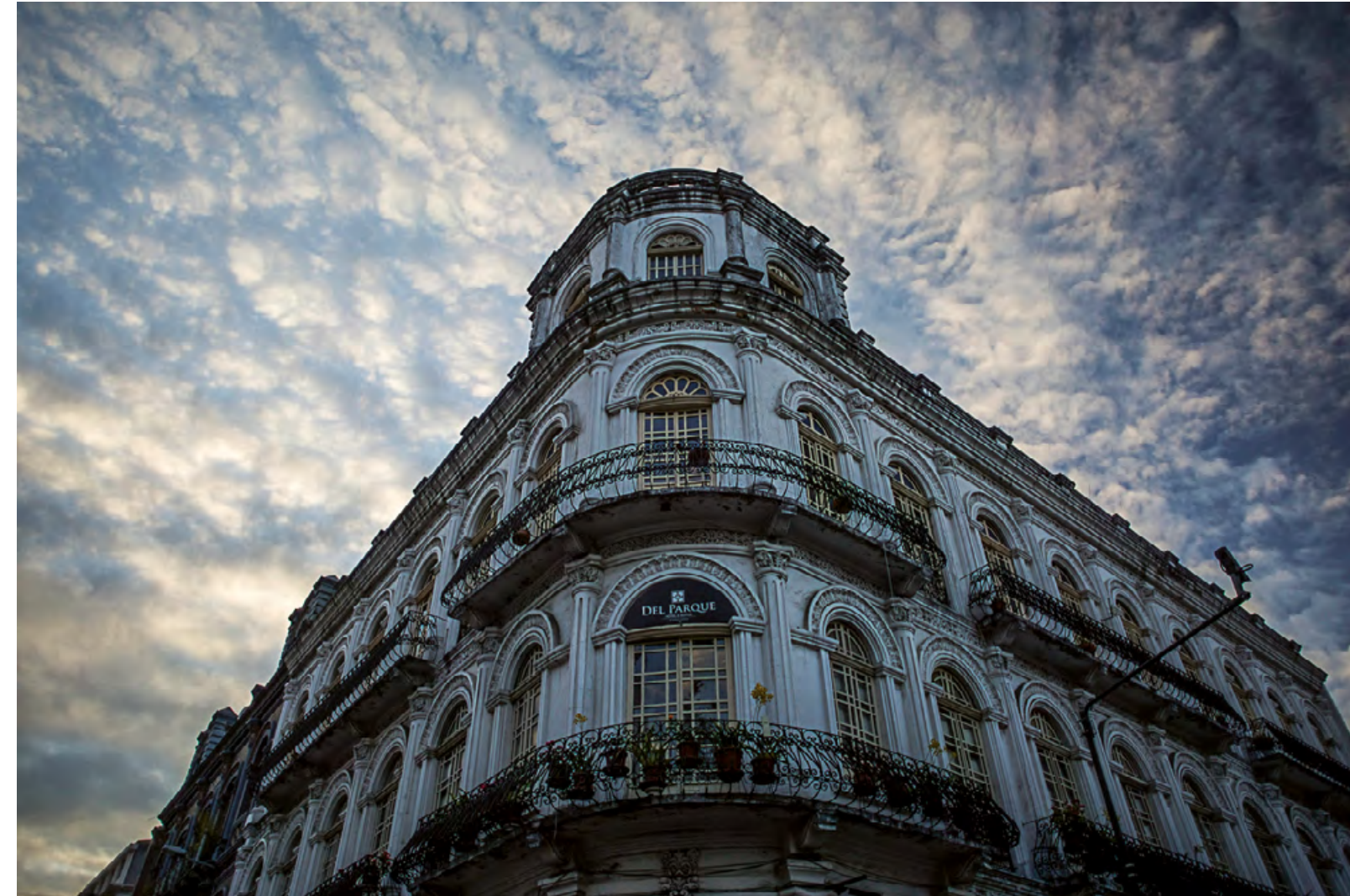
Casa Montesinos-Arce, calles Benigno Malo y Bolívar. Arquitecto: Juan Bautista Stielhe, construcción 1898-1907. Foto: Juan Carlos Astudillo
